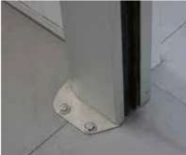
Detalle de fijación al suelo
